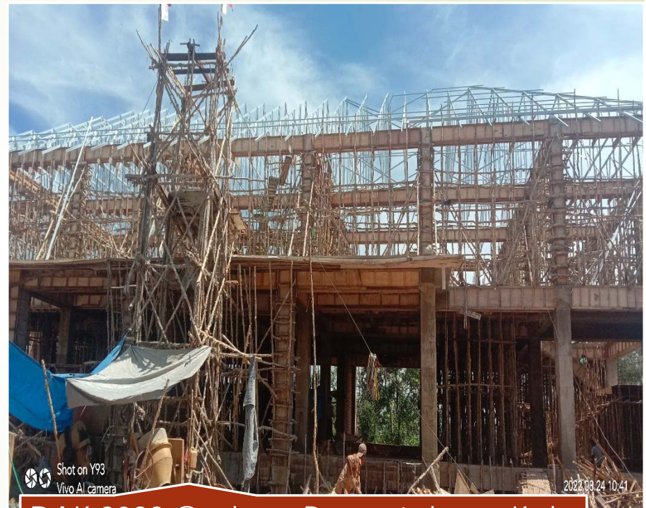
DAK 2022 Gedung Perpustakaan Kab. Barito Kuala Kalimantan Selatan – Progress 60%
