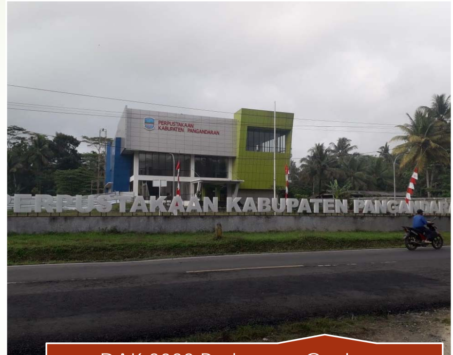
DAK 2022 Perluasan Gedung Perpustakaan Kab. Pangandaran Jawa Barat- Progress 88%
