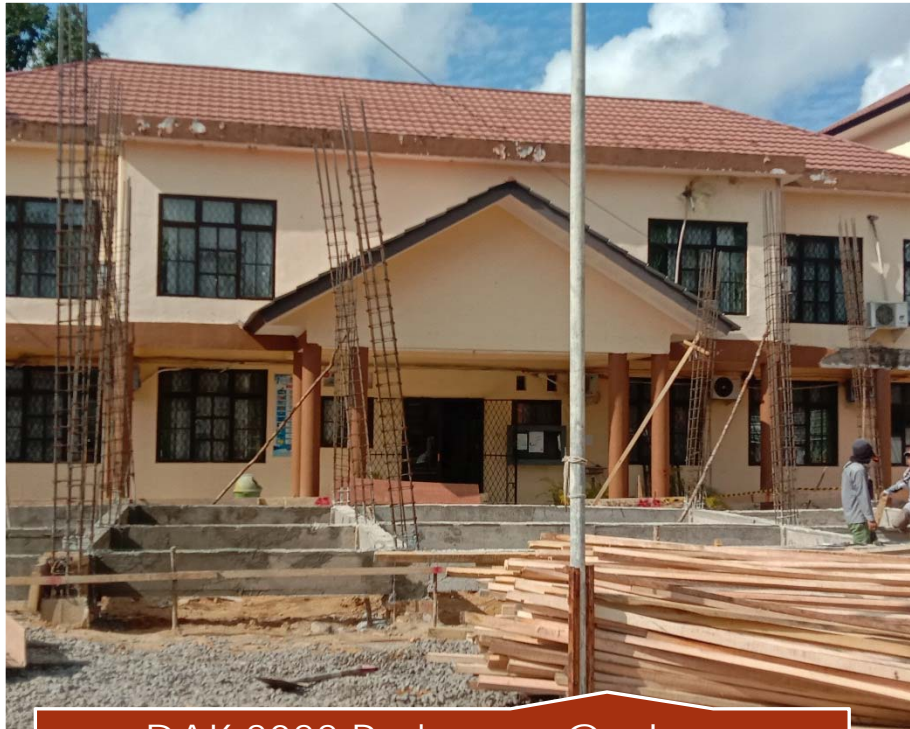
DAK 2022 Perluasan Gedung Perpustakaan Kota Pangkalpinang- Progress 10%
