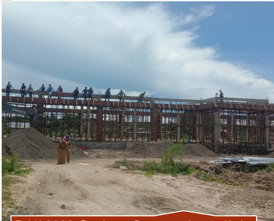
DAK 2022 Gedung Perpustakaan Kab. Halmahera Tengah Maluku Utara – Progress 35%
