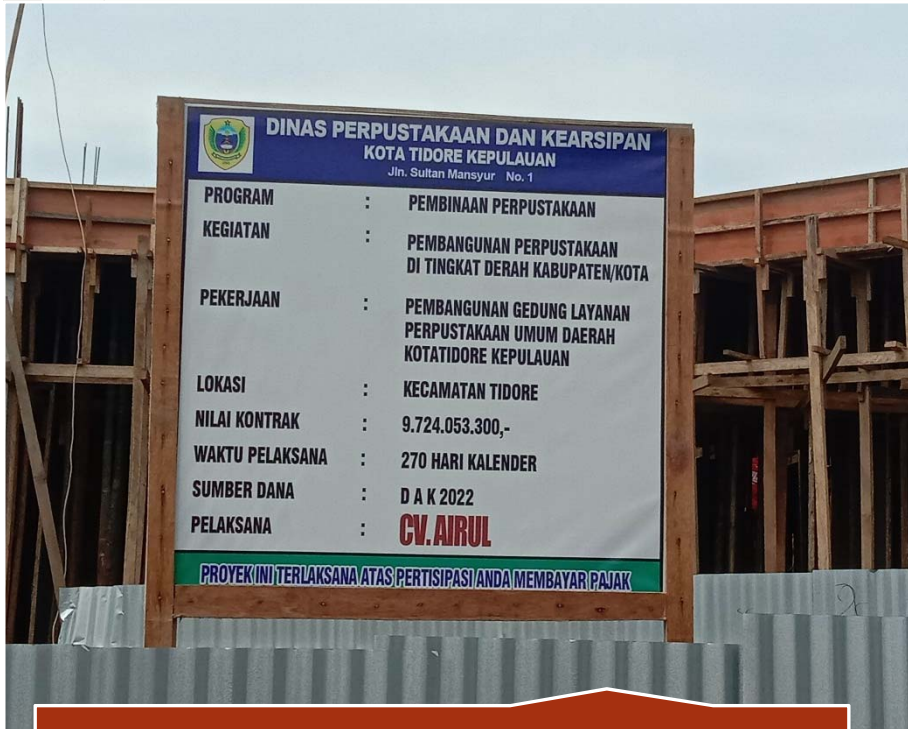
DAK 2022 Gedung Perpustakaan Kota Tidore Kepulauan-Progress 32%
