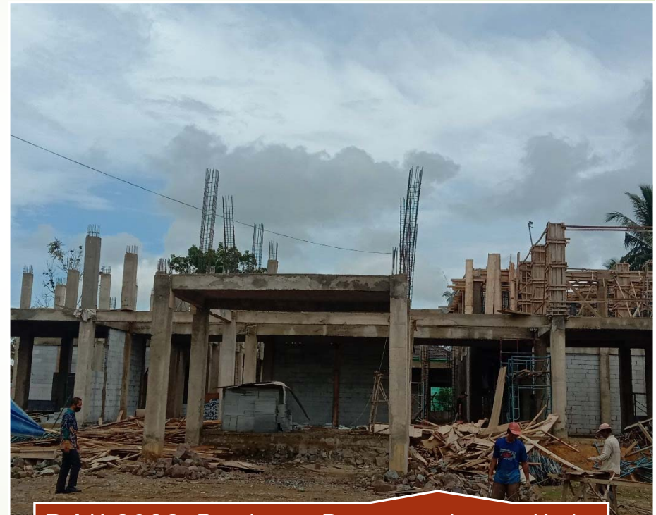
DAK 2022 Gedung Perpustakaan Kab. Hulu Sungai Selatan Kalimantan Selatan – Progress 35%
