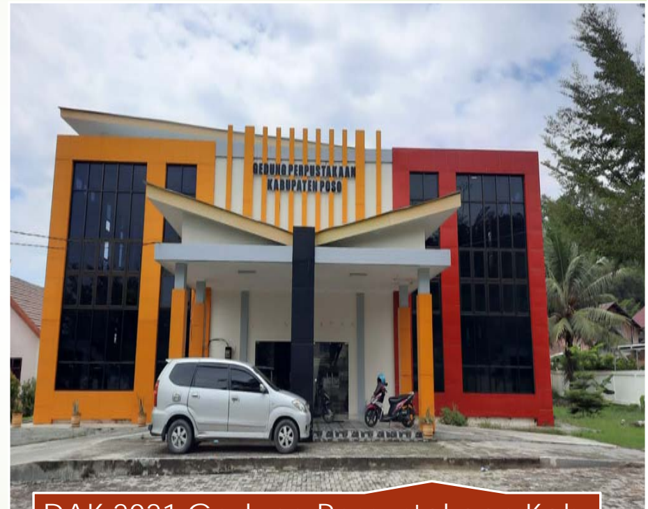
DAK 2021 Gedung Perpustakaan Kab. Poso Sulawesi Tengah-Sudah difungsikan
