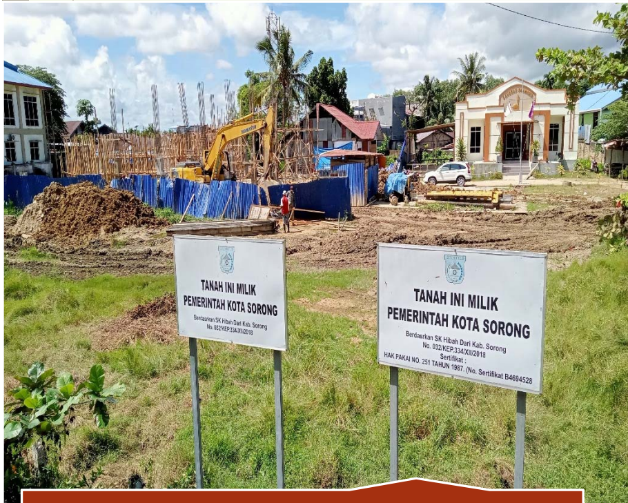
DAK 2022 Gedung Perpustakaan Kota Sorong-Progress 20%
